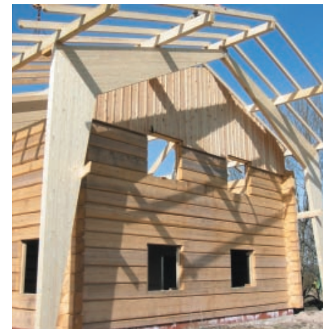
Der 120 qm Wohnteil unter der Dachkonstruktion eines Blockhaus-Gehöftes.
