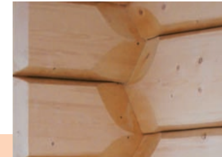
Der beidseitig besäumte Blockbalken mit norwegischer Sattellecke.
