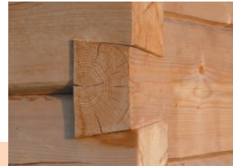
Die Schwalbenschwanz-Verkämmung am Vierkant aus Naturstämmen.
